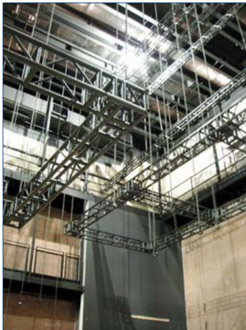
Aerial view of grid with its trusses /Vue aérienne du grid et du système d'accrochage
